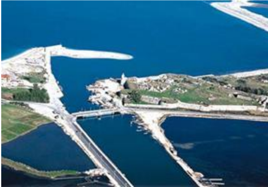
Η υποθαλάσσια γέφυρα Ακτίου- Πρέβεζας
